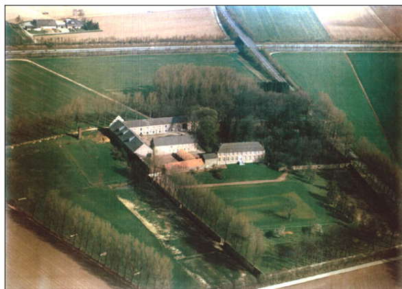
Abb. IV.64: Luftaufnahme des ehemaligen Klosters Hohenbusch, undatiert, Ende 20. Jh.
