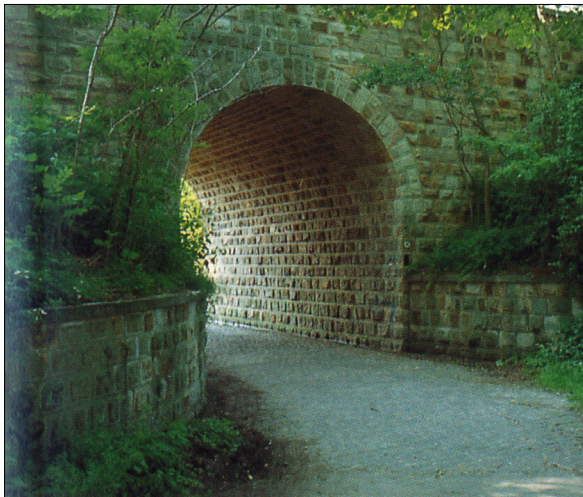
Abb. III.19: Die Unterführung des Bahndammes bildet das Eingangstor in die Bentlager Landschaft.
