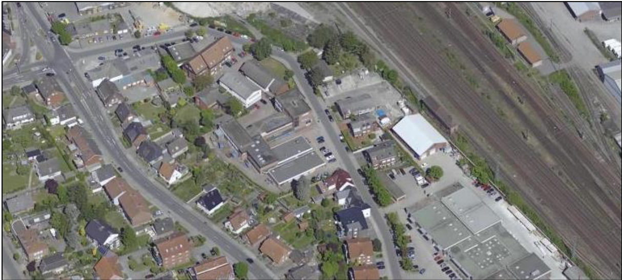
Abbildung 3: Schrägluftbild (Gebäudebestand vor Abriss)
