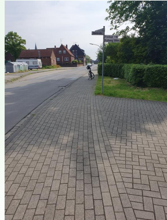
Einmündung Bevergerner Straße / Diekbrede
